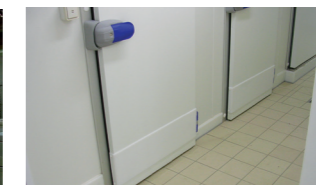
Chambres froides et locaux de surgélation
